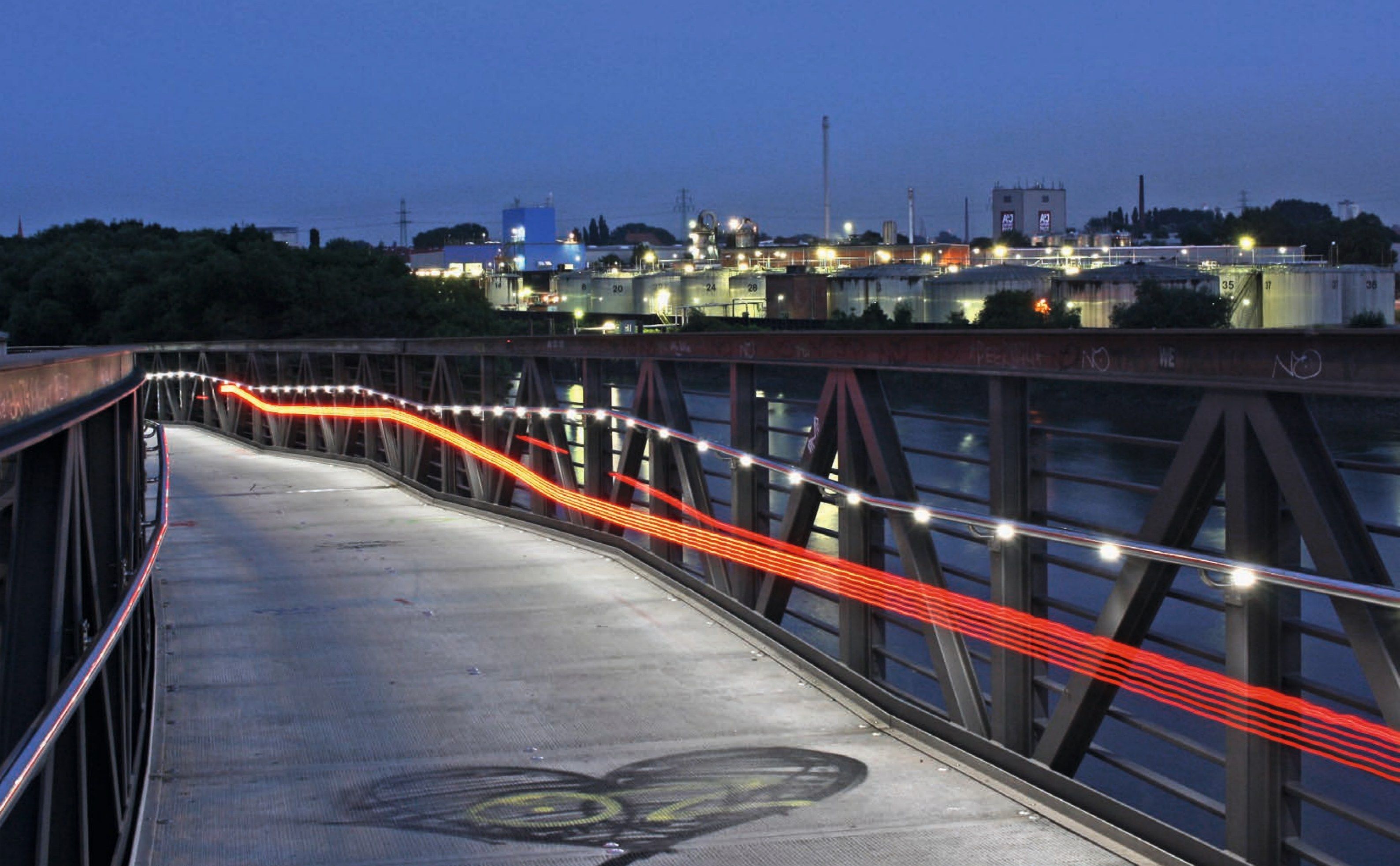
Klütjenfelder Geh- und Radwegbrücke
