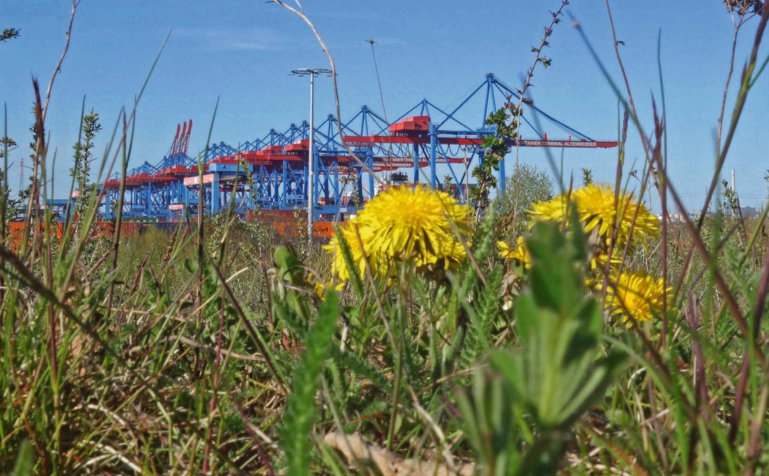
Container Terminal Altenwerder
